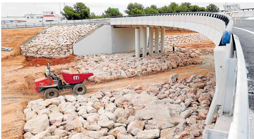
Trabajos en la colocación de escollera en el puente de acceso a Bonaire. JESÚS SIGNES
