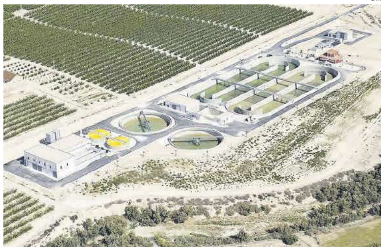
Una imagen de una Estación Depuradora, en Alguazas.
